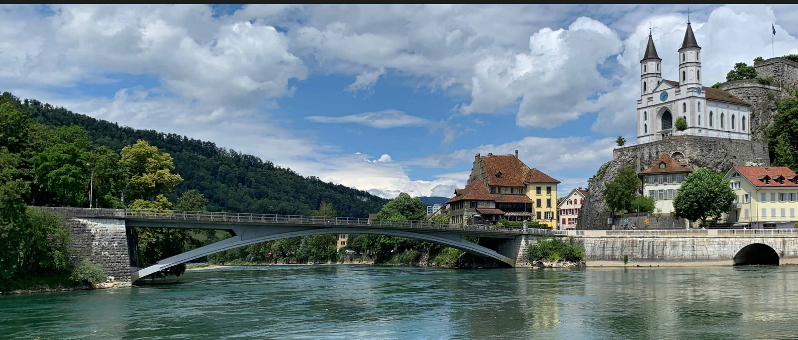
Maillartbrücke über die Aare in Aarburg
